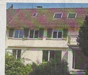
Gartenseite vor dem Umbau: Im Dach die klassischen Dachfenster.
