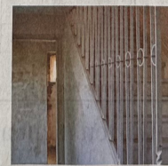
Vorher war es dunkler – Blick auf die Treppe vor dem Umbau.
